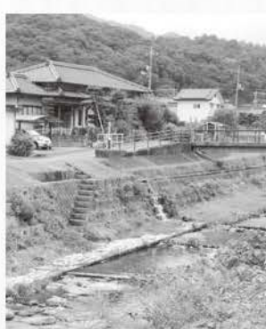
車橋周辺の吉敷川
