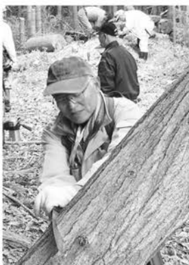
吉敷大峠開通作業
