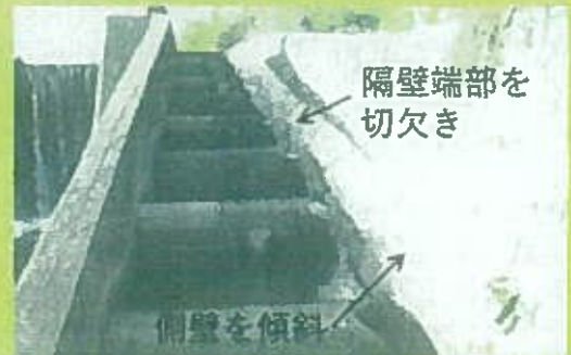
小わざ魚道（側壁・隔壁の加工）
