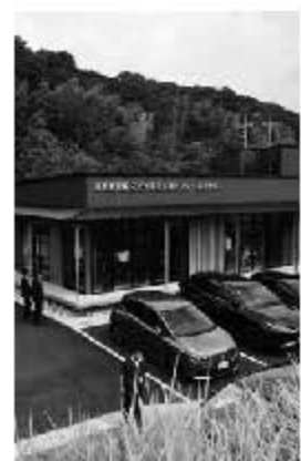
新設された施設
